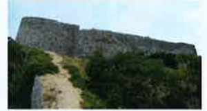
勝連城跡 かつれんじょうあと 12～13世紀頃築城。「護佐丸・阿麻和利の乱」で名高く阿麻和利の居城。4から3そして2、1の曲線へと階段状に上る造りである。1の曲線からの眺めが素晴らしい。
